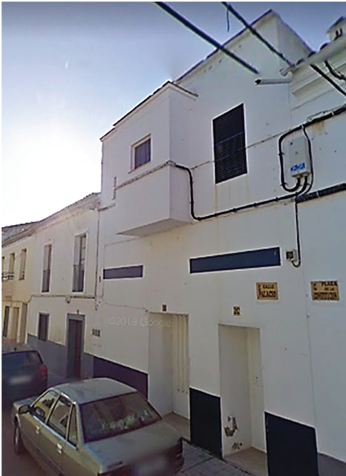
Figura 1. Calle Palacios n°s 2 y 4, Salorino: Cine San Ildefonso antes de la reforma. ©Google Maps (s.f.)
