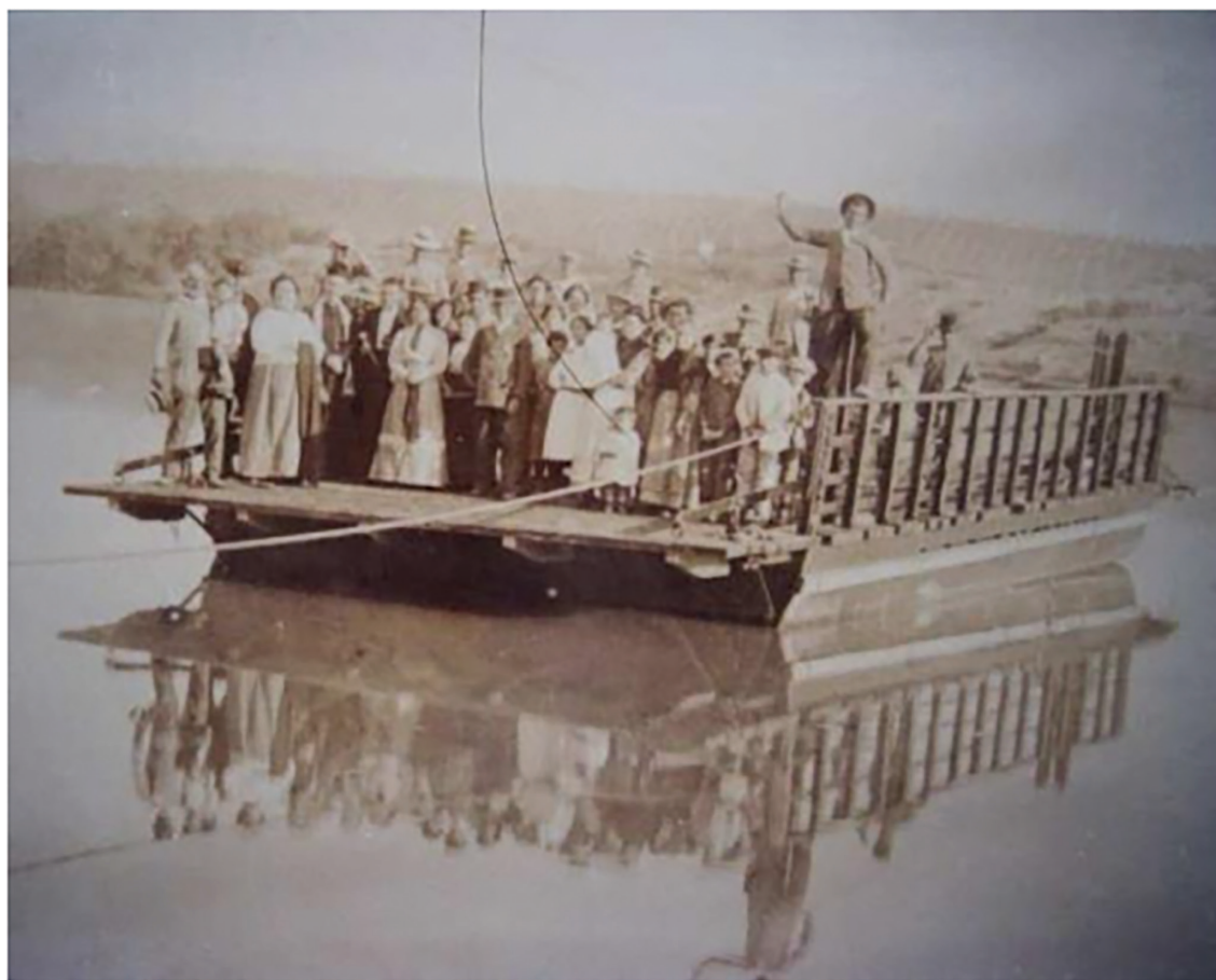
Imagen 3. La barca de puente de Cantillana
